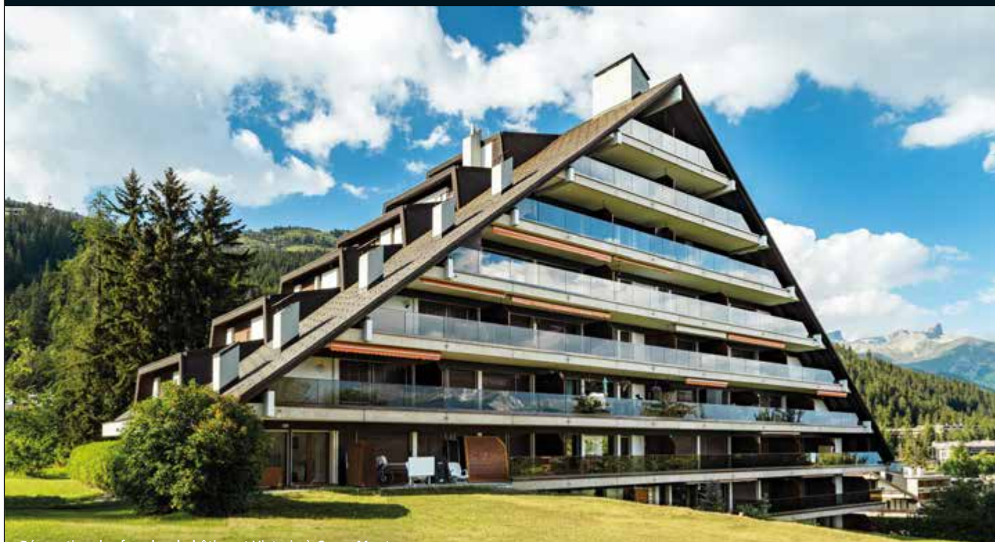
Rénovation des façades du bâtiment Victoria à Crans-Montana
