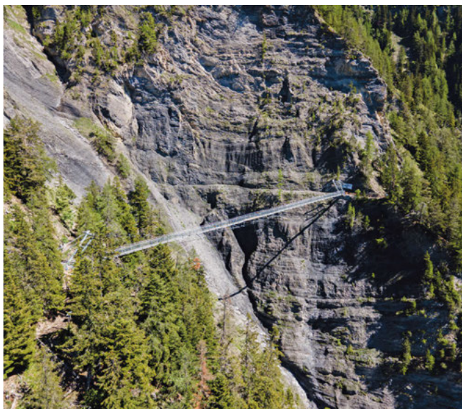
Passerelle-bisse du Rhô
