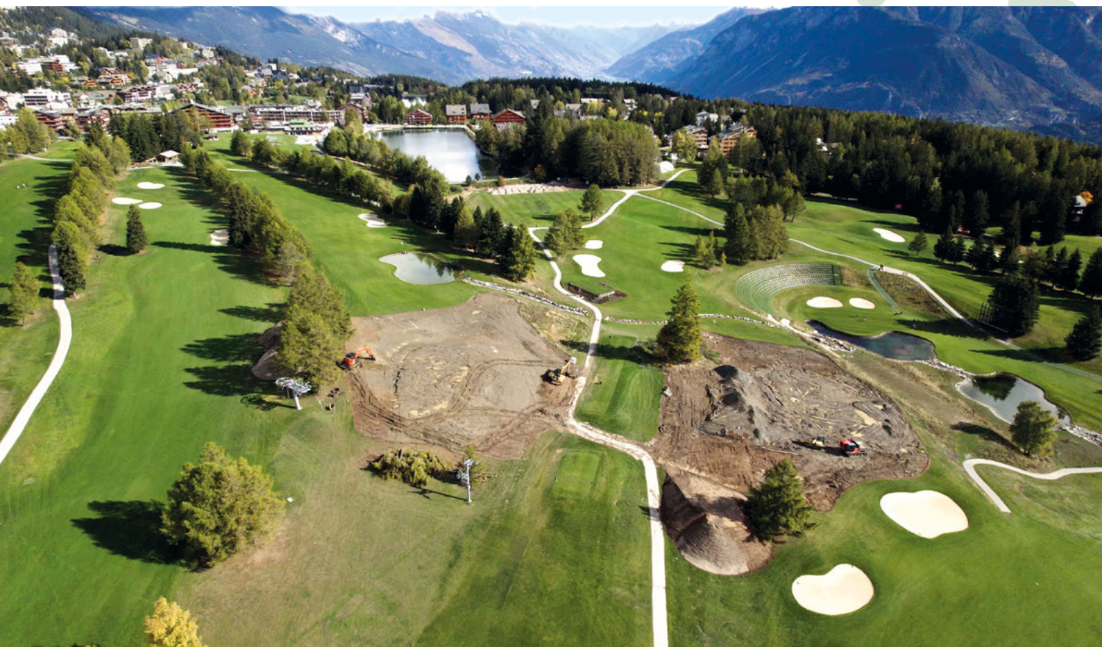
Durant l'hiver 2023-2024, les travaux de rénovation se sont concentrés sur les trous No 10 et 17
